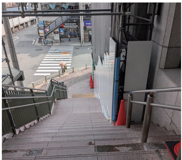
工事のため設置された仮囲みで通常より階段の幅が狭くなっている
