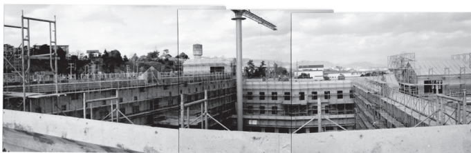
建設中の新学生会館＝関西学院学院史編集室提供
