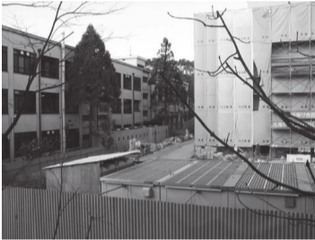
建設工事中のB棟
